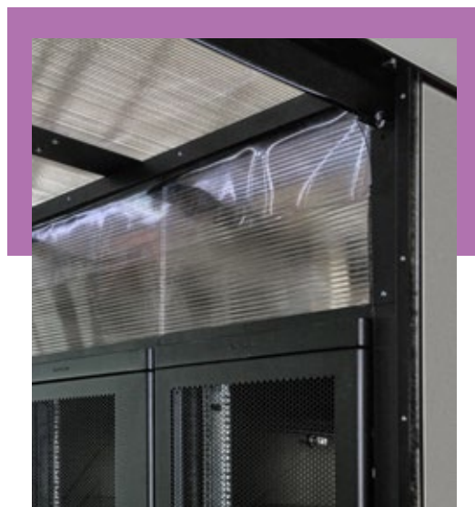
панели могут обрезаться по месту до требуемого размера
